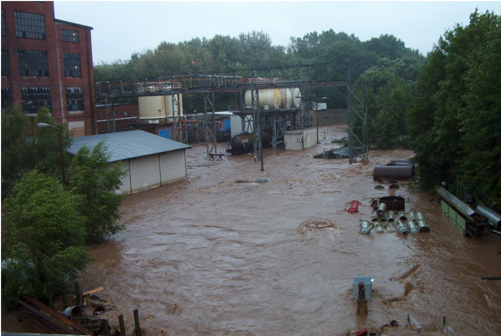
Abbildung 1: Überflutete Chemieanlage in Sachsen
